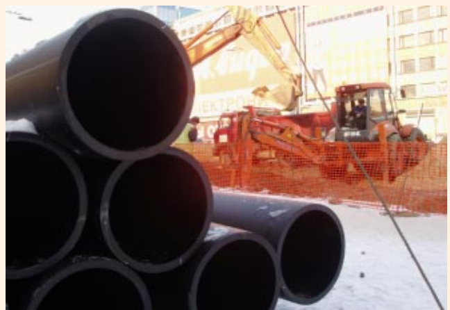
Реконструкция систем городского Санкт-Петербурга с применением современных труб из ПЭ 100
