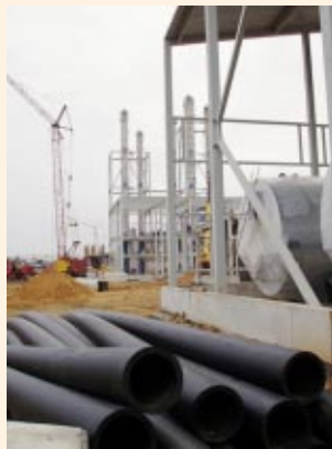
Применение ПЭ труб для систем водопровода, в том числе системы пожаротушения, при строительстве завода на Пулковском шоссе, Санкт-Петербург
