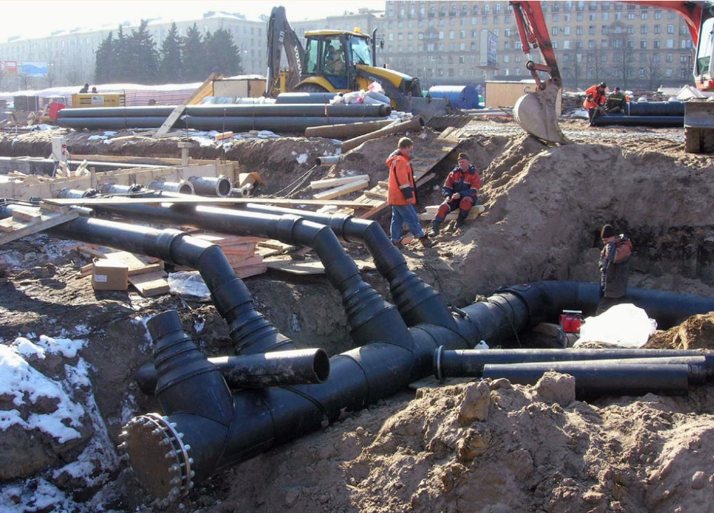
В кратчайшие сроки именно из ПЭ труб были изготовлены и поставлены сложнейшие узлы для фонтанного комплекса на площади у метро Московская.
